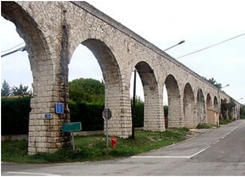
Pont aqueduc de Calèche
