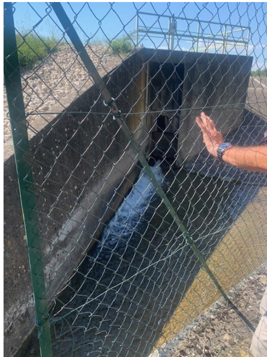
Alimentation des cours d'eau de la Malavalasse et de la Malaurie
