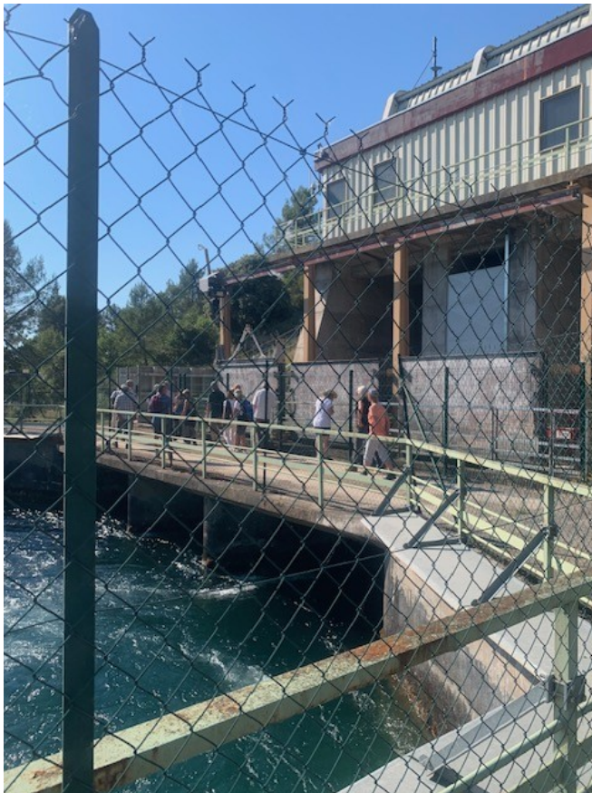
Ouvrage servant à « casser » la force du courant
