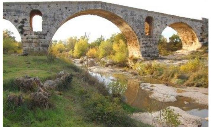
Gaule) ses ouïes percées dans les piles et sa chaussée très élevée au-dessus de la rivière, le nouveau pont permettait un meilleur écoulement des eaux et un franchissement sécurisé (en dehors des normes Européennes !!).
