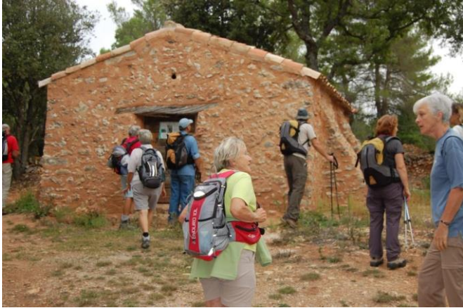
Four à pain rénové
